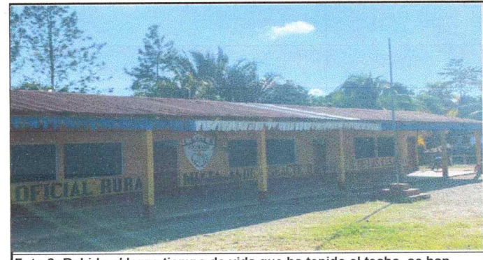
Foto 6: Debido al largo tiempo de vida que ha tenido el techo, se han caido por el viento, algunas láminas que han tenido que ser sustituidas, el resto se encuentran muy frajiles debido al oxido que las ha carcomido.
