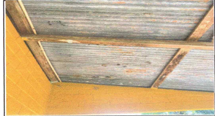
Foto 4: Las costaneras del modulo del centro educativo se encuentran podridas, las laminas tienen más de treinta años de vida, el tiempo las ha deteriorado.
