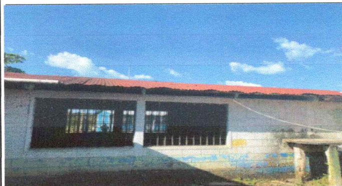
Foto 5: Debido al mal estado de las costaneras, el techo del centro educativo se ha levantado, corriendo el riesgo de que un viento desprenda por completo el techo del establecimiento
